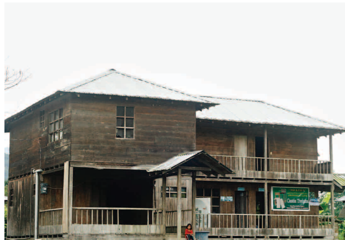
Instalaciones de Asokanus
